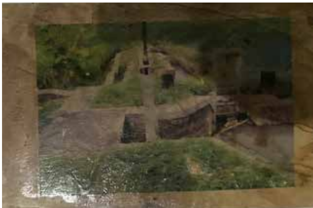
Gambar 12 Hasil karya tembuku (bangunan pembagi).
