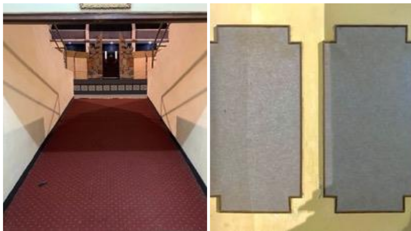
Gambar 4. Permukaan Absorber Material dalam gedung pertunjukan Candra Metu. (Sumber: Grace Alexandra, 2022)
